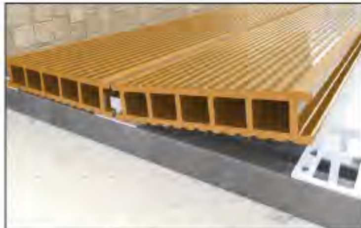
4)- Aynı işlem diğer Deck'lerin de yerleştirilmesi şeklinde gerçekleştirilir.
