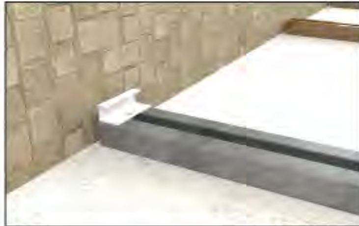
1)- Diğer karkaslarda olduğu gibi başlangıç klipsi yerleştirilir.
